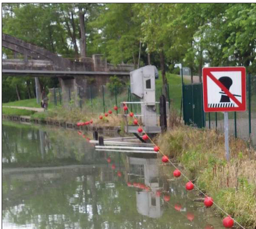
Prise d'eau pour l'alimentation en eau brute de l'usine d'eau potable voisine
