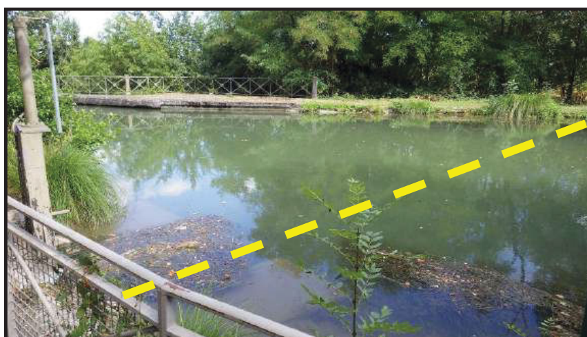
Vue de l'aval du cinquième site de jaugeage
