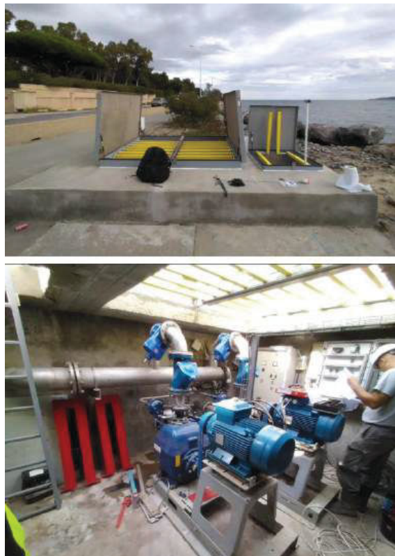
Figure 13 : Exemple de fosse de relevage avec deux compartiments
