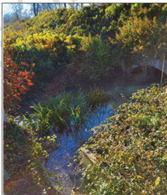
Figure 2 : vue de l'exutoire sous le canal au PK 233+510 au 14/12/2021 côté V2
