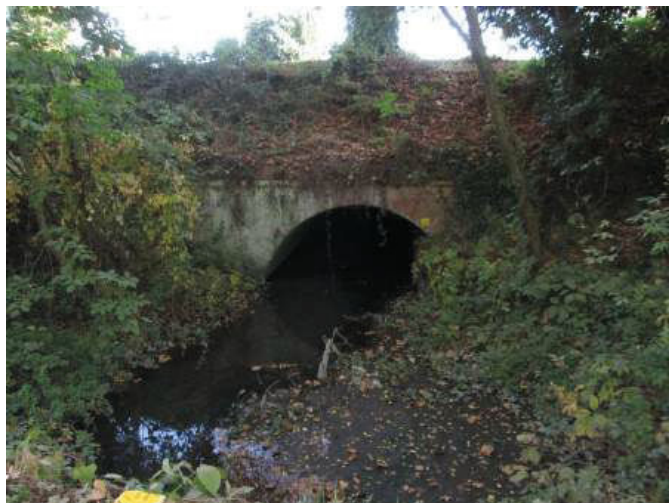
Photo 7 : Extrémité aval de l'ouvrage-voute situé sous le canal
