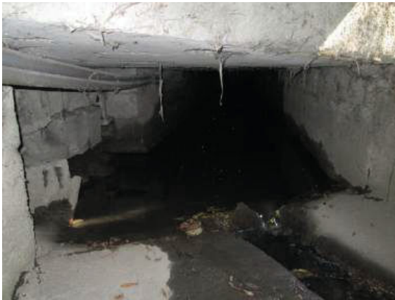
Photos 5 et 6 : Extrémité aval de l'ouvrage-cadre situé sous le site Liebherr et extrémité amont de l'ouvrage-voute sous la parcelle privée en aval d'avenue des Etats-Unis
