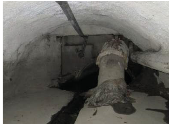
Photos 5 et 6 : Extrémité aval de l'ouvrage-cadre situé sous le site Liebherr et extrémité amont de l'ouvrage-voute sous la parcelle privée en aval d'avenue des Etats-Unis
