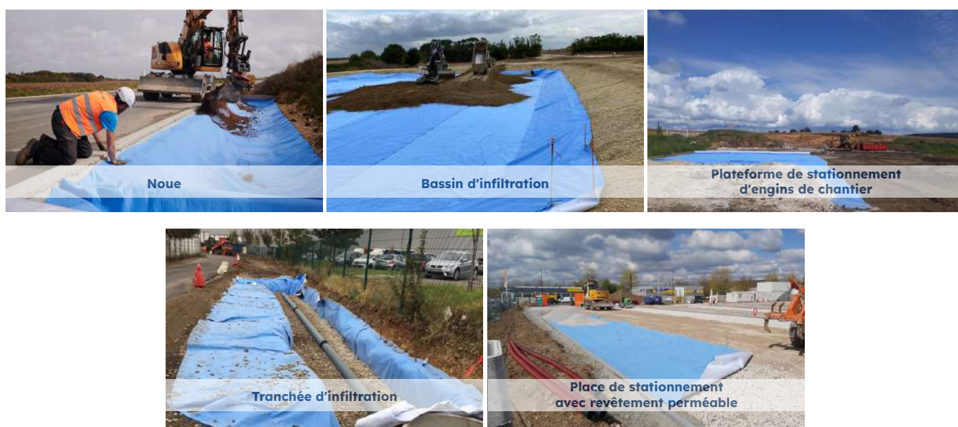
Figure 2 : Exemples d'ouvrages d'infiltration
