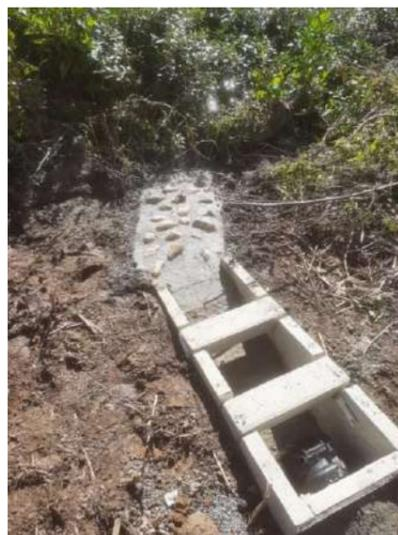
La canalisation et le point de rejet en berge seront implantés de façon à préserver au maximum les arbres formant la ripisylve et en particulier les arbres remarquables (mise en défens).
