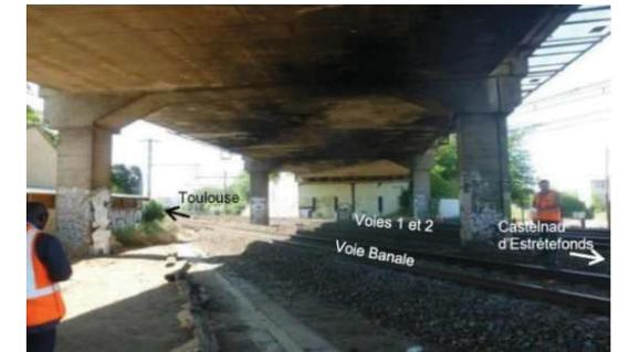
Ouvrage à une travée unique situé au Km 251+496, son tablier est supporté par quatre piles intermédiaires dont deux sont implantées entre les voies rapides de Bordeaux-Sète et la voie banale.
