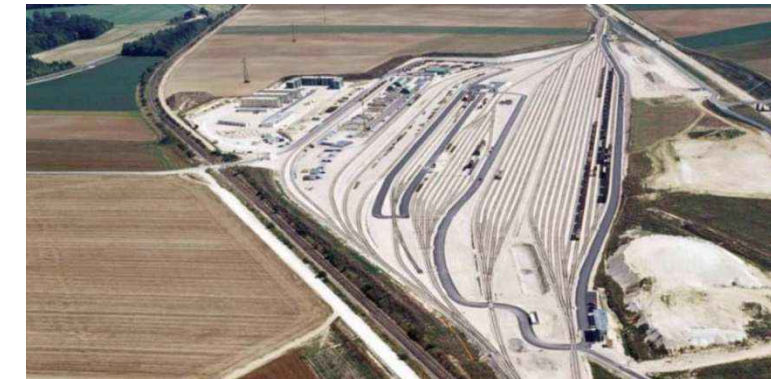
Figure 76 : Exemple de base travaux de Vadenay – Saint-Hilaire au Temple (51) sur la LGV Est européenne (Source : SNCF Réseau)
