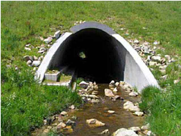
Figure 59 : Exemple d'ouvrage aménagé avec banquettes latérales pour la faune semi-aquatique (Source : Egis)
