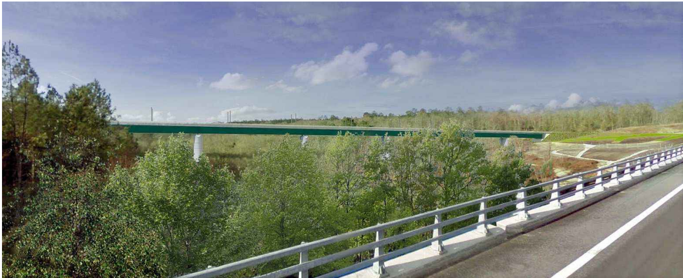
Figure 53 : Exemple d'ouvrage de type viaduc : viaduc de la Douze aux environs de Roquefort (source : Egis 2013)
