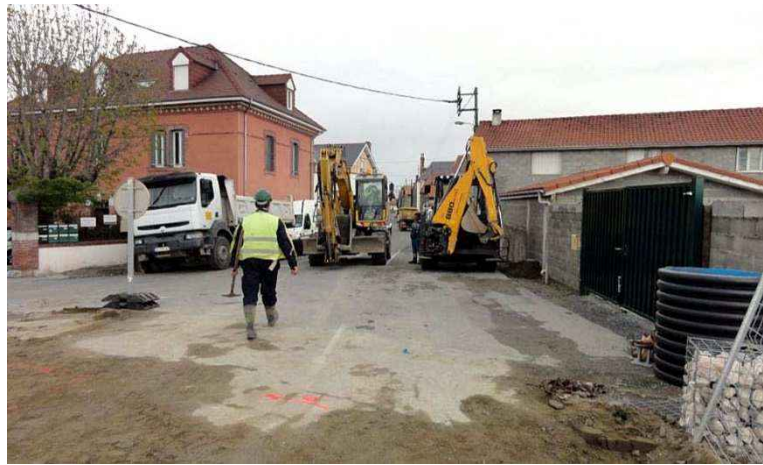
Figure 74 : Travaux à proximité de zones urbanisées (Source : Egis, 2012)
