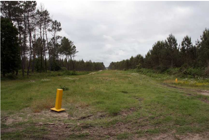
Figure 13: Canalisation de gaz à Cudos en Gironde (Source Egis 2012)
