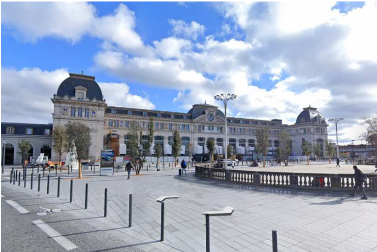
Figure 3: Gare de Toulouse-Matabiau (Source : Google Earth, 2025)
