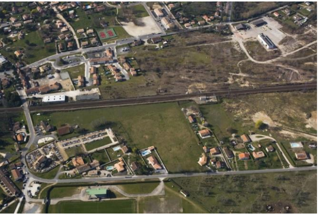
Figure 70: Sous-station existante à Saint-Médard-d'Eyrans (Source : SNCF Réseau)
