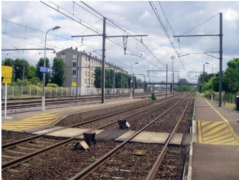
Figure 73: Ligne existante Bordeaux – Langon (Source : Egis, 2012)
