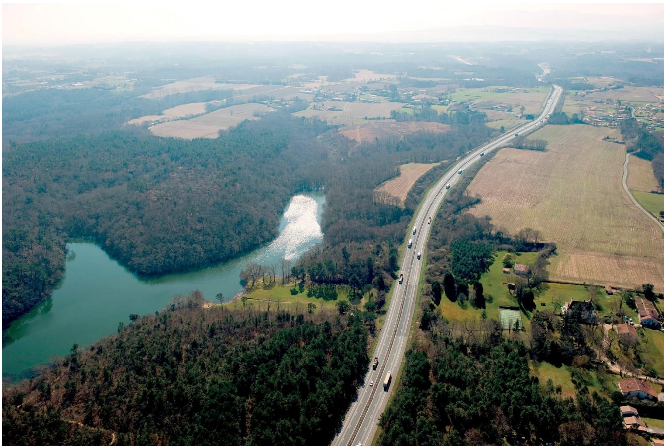
Figure 21: A63 au niveau des étangs de Beyres (Source : SNCF Réseau)
