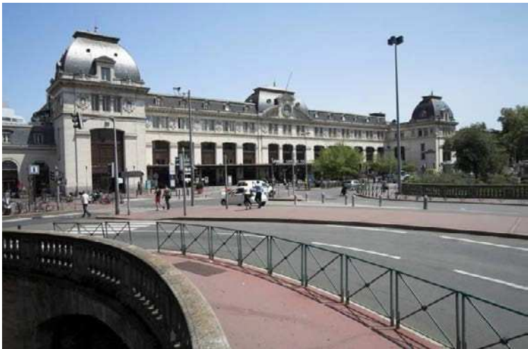
Figure 17 : Gare de Toulouse Matabiau (Source Inexia)
