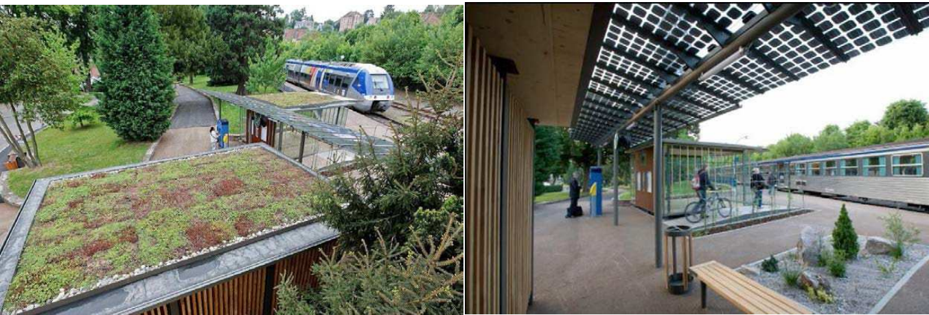
Figure 5 : Halte ferroviaire de Niederbronn-les-Bains en Alsace (Source : SNCF)
