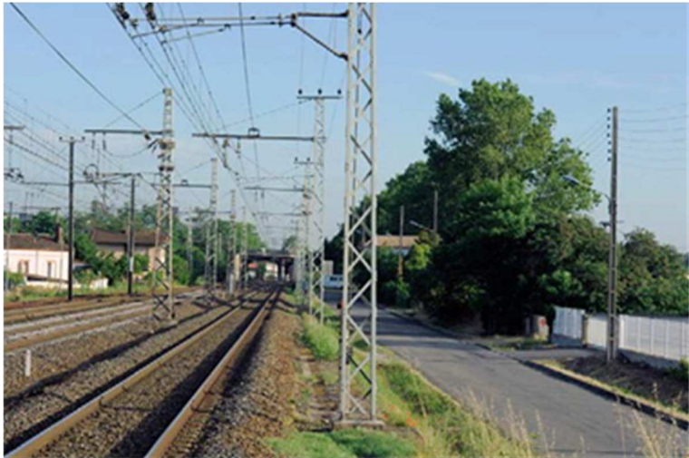
Figure 51: La ligne existante Bordeaux - Sète et la RD820 à l'approche de l'agglomération toulousaine (Source : Systra)
