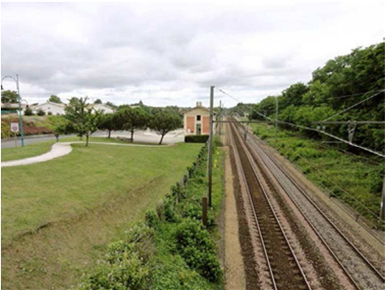
Figure 45: Ligne existante entre Bègles et Saint-Médard-d’Eyrans (Source : Egis, 2012)
