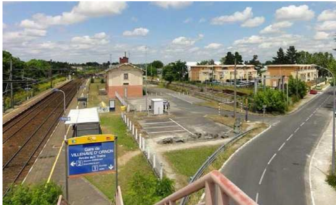
Figure 11 : Halte de Villenave-d’Ornon (Source : Egis, 2012)
