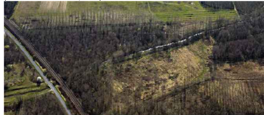
Le Saucats en amont du franchissement par la ligne ferroviaire Bordeaux-Sète (Source : SNCF Réseau, 2012)
