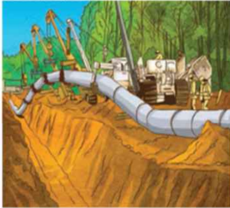
Mise en fouille
