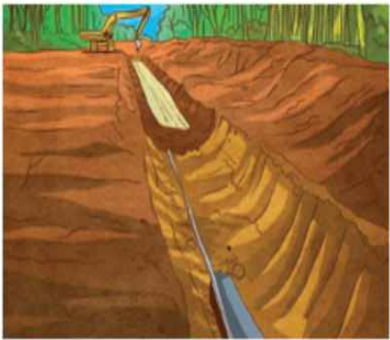
Mise en place du grillage avertisseur
