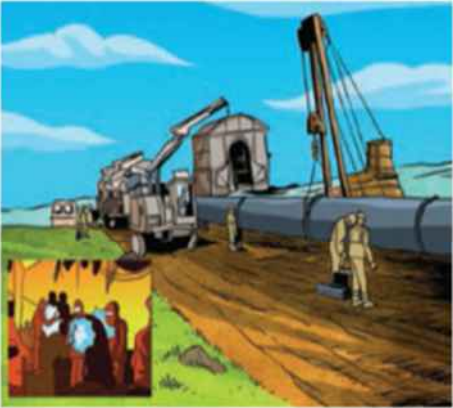
Soudage des tubes et revêtement des joints
