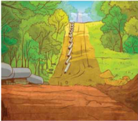
Transport et alignement des tubes
