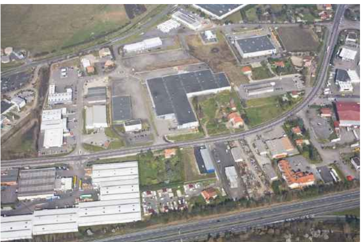
Figure 6: Zone d'activités de Treil sur Le Passage (Source : FIT Conseil)
