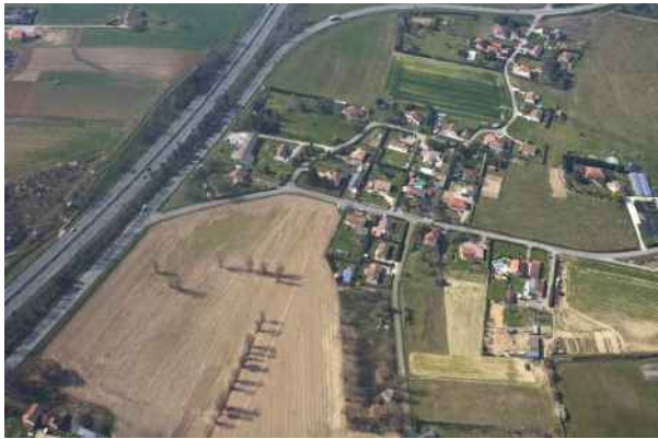
Figure 15: Vue sur l'A62 au niveau de Puits de Carrère sur la commune d'Estillac (Source : SNCF Réseau, 2012)
