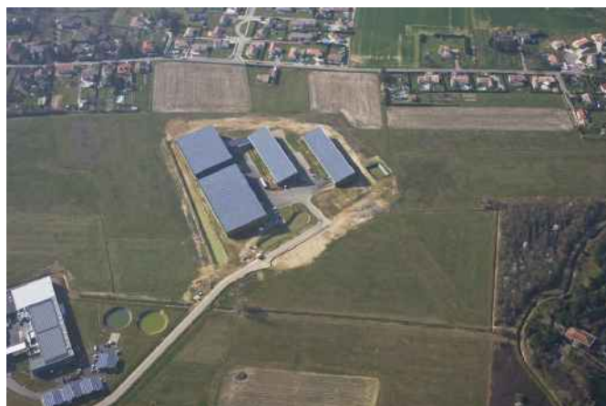
Figure 4 : Zone d'activités Sun Valley à Roquefort (Source : FIT Conseil)
