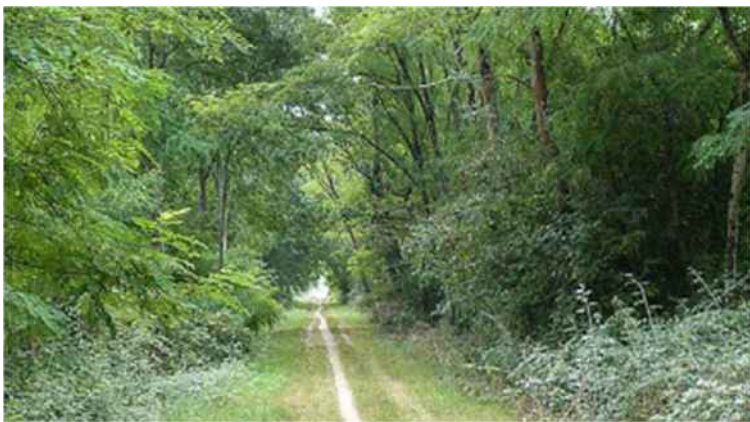
Figure 57: Digue arborée du Canal latéral de la Garonne, Brax (Source : Soberco, 2010)
