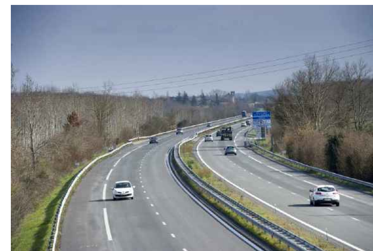
Figure 14: La Route Départementale 656 au niveau de « Le Sarailier » sur la commune de Roquefort (Source : Egis, 2012)
