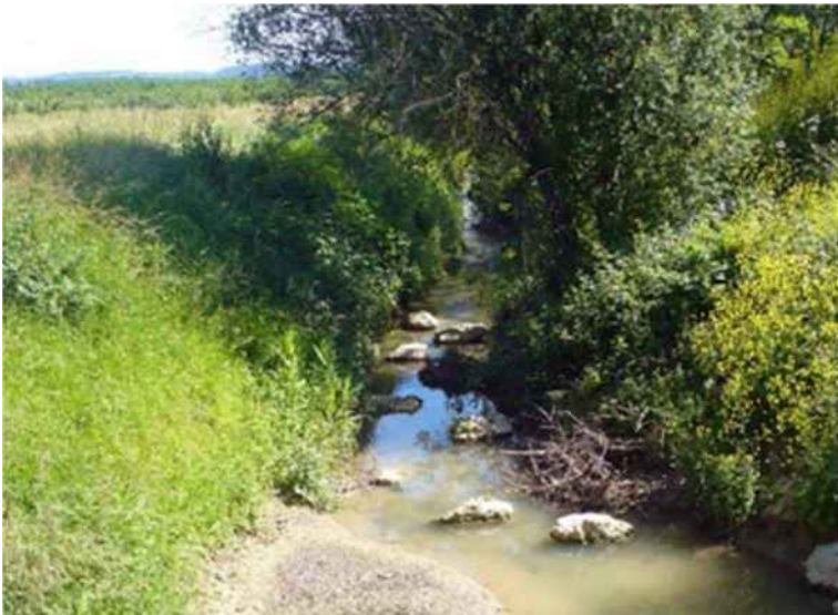
Figure 27: Ruisseau de Labourdasse au niveau de son rétablissement le long de l’A62 sur la commune de Roquefort (Source : Egis)
