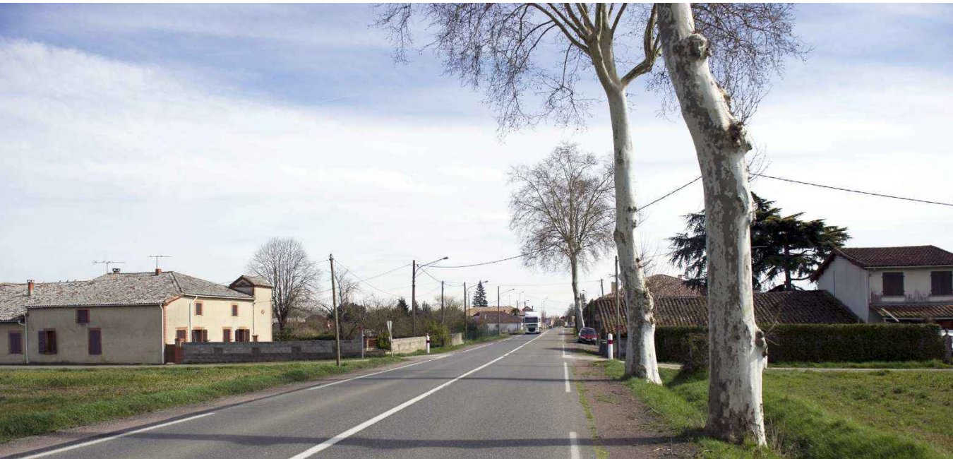
Figure 12: RD 813, commune de Saint-Porquier (Source : SNCF Réseau - Paul Robin)
