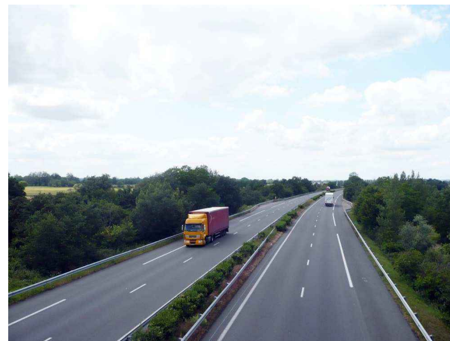
Figure 9: L'autoroute A62 au niveau du pont de la route départementale 14 sur la commune de Saint-Porquier (Source : Egis)
