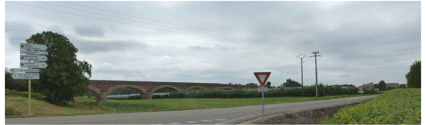
Figure 70: Vue sur la RD26 à proximité de l'abbaye de Belleperche (Source : Soberco, 2010)
