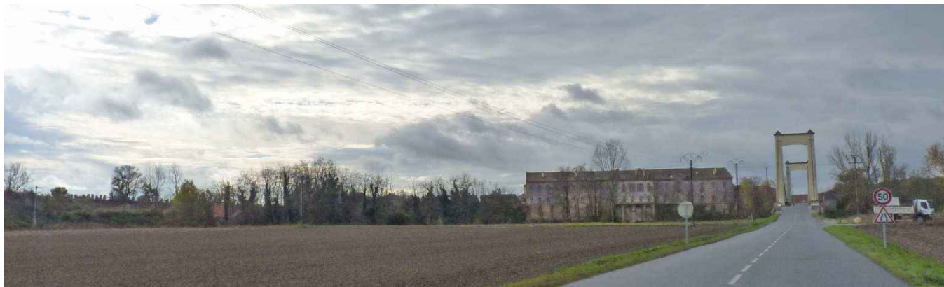
Figure 69: Vue sur le coteau de la Garonne et les abords arborés de la Gimone à Cordes-Tolosannes (Source : Soberco, 2010)
