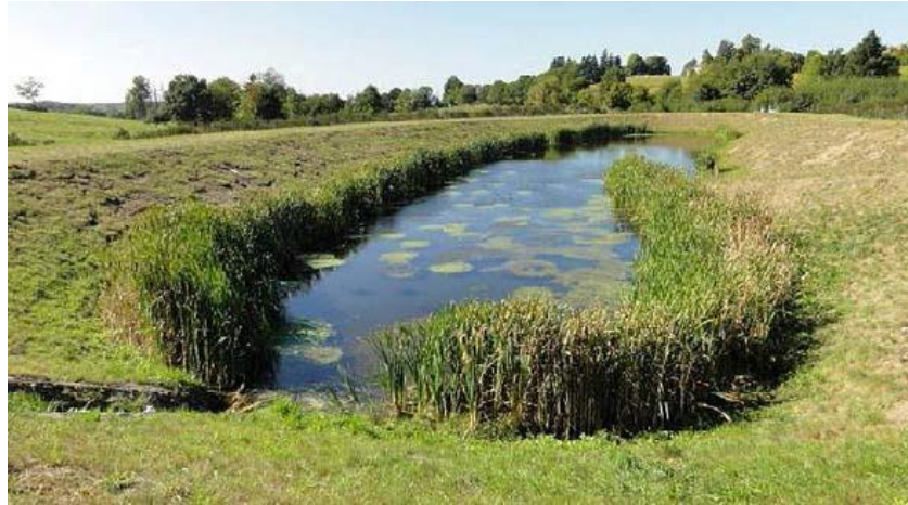
Figure 165: Exemple de bassin de rétention (Source : Egis)
