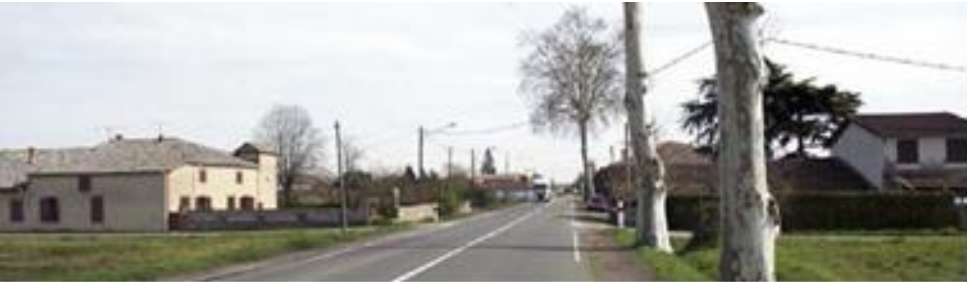
Figure 134: Bâti à Saint-Porquier (Source : SNCF Réseau)
