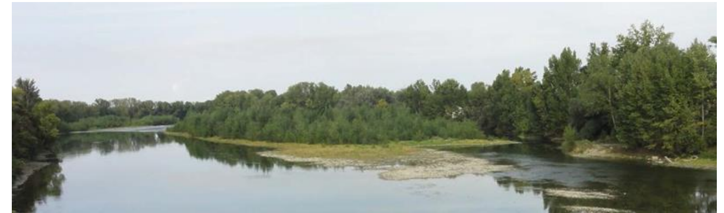
Figure 162: La Garonne au niveau de Castelferrus (Source : SNCF Réseau)
