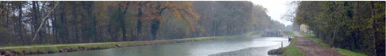
Figure 121: Le canal de Montech (Source : SNCF Réseau)
