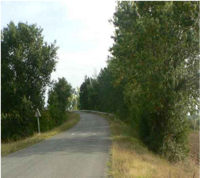
Figure 67: Corridor boisé favorisant la traversée de l'A62 au niveau d'un passage supérieur (Montesquieu, 47) (Source : EKO-LOGIK)
