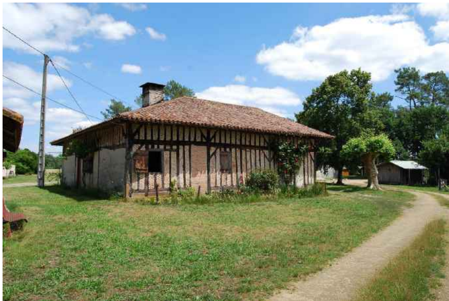
Figure 109: Bâti landais à l’architecture traditionnelle, arial Soumard, Begaar. (Source : Egis, 2011)
