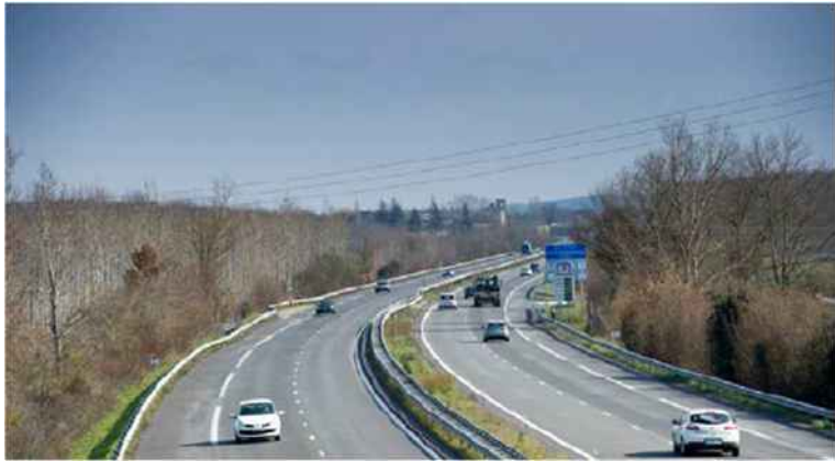
Figure 128: Autoroute A62 (Source : SNCF Réseau)
