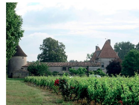
Figure 189: Château d'Eyrans sur la commune de Saint-Médard-d'Eyrans (Source : ISA, 2011)
