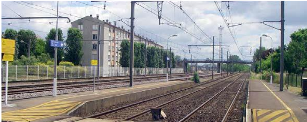
Figure 166: Ligne existante Bordeaux-Sète (Source : Egis, 2012)
