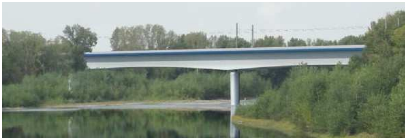
Figure 127: Exemple d'ouvrage de type 1 (Source : Egis)
