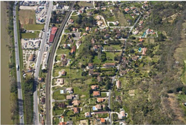
Figure 83: Zone de risque géologique sur la commune de Colayrac-Saint-Cirq, au Nord de la RD113, source : google Eaath
