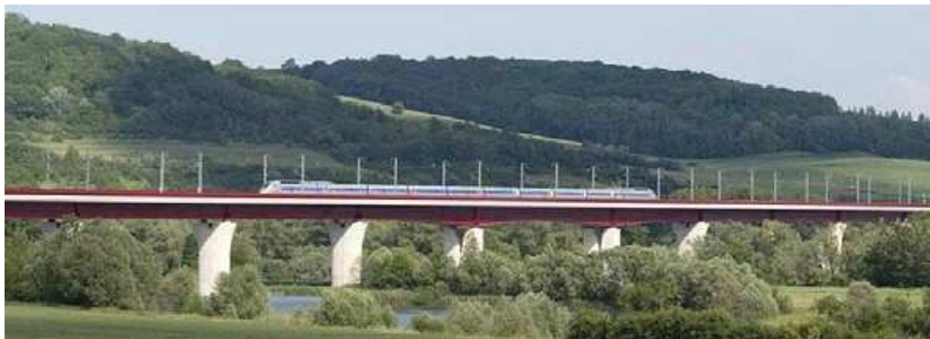
Figure 128: Exemple de viaduc enjambant le lit mineur et les berges (Source : SNCF RÉSEAU)
