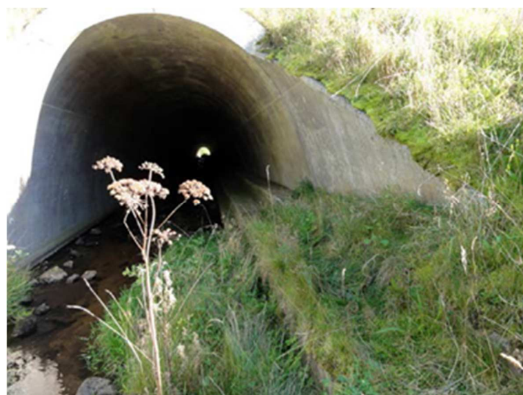
Figure 124: Ouvrage aménagé pour la faune semi-aquatique (Source : Egis)
