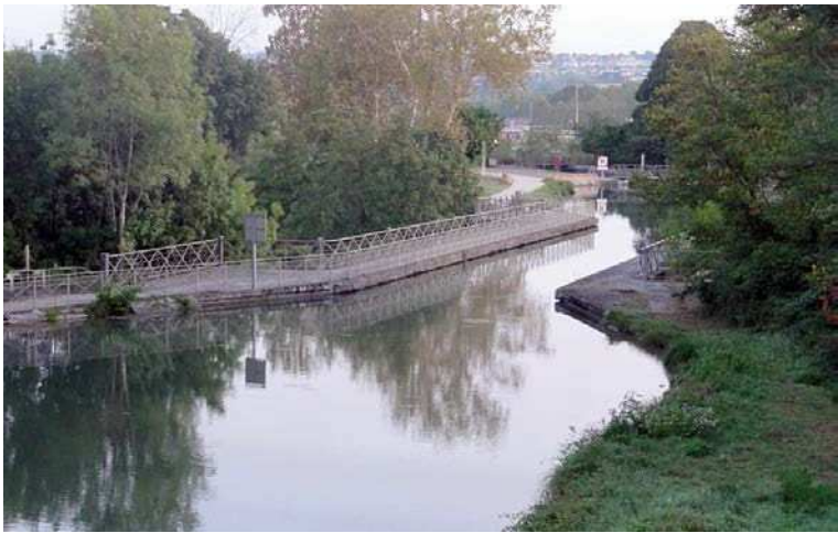
Figure 86: Prise d'eau destinée à l'AEP dans le canal latéral à la Garonne sur la commune de Saint-Jory (Source : Egis, 2012)
