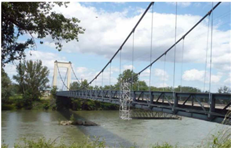
Figure 91: Franchissement de la Garonne à Belleperche (Source : Egis, 2012)
