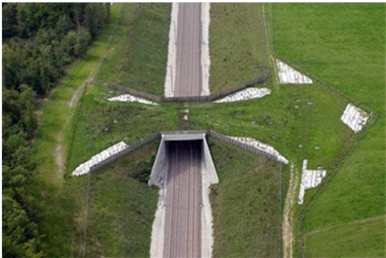
Figure 116: Ouvrage spécifique supérieur (Source : SNCF RÉSEAU)
