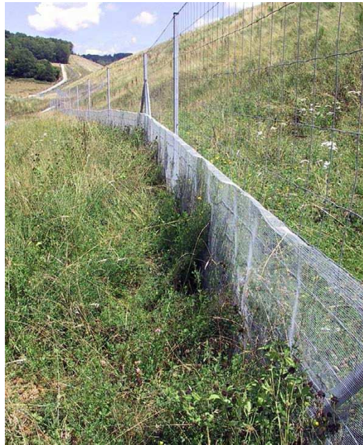
Figure 115: Clôture à maille fine interdisant l'accès aux amphibiens (Source : Egis)
