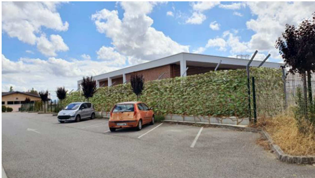
Exemple de la sous-station du Vernet :
