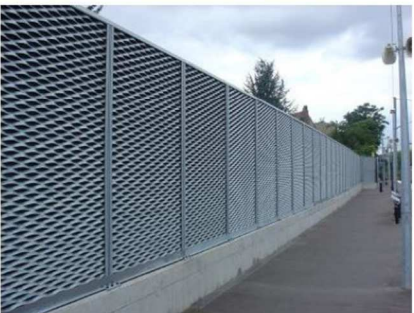
Exemple d'écrans acoustiques avec un bardage en métal déployé
