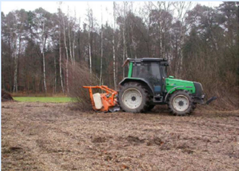
Figure 340 : Opération de broyage – Renaturation de zones humides, CSA
