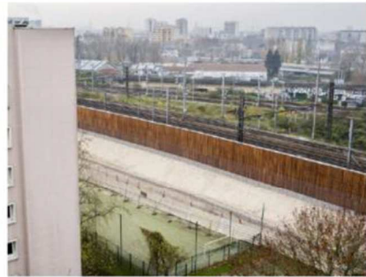
Aménagement d'un écran acoustique sur le domaine ferroviaire en interface avec la cité Paul Eluard - Projet SNCF - Saint-Denis (93)
