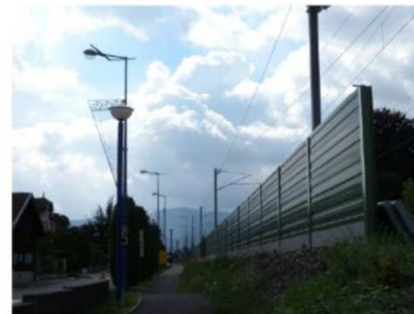
Aménagement et intégration d'un écran acoustique avec la mise en oeuvre de gabions végétalisés - mur acoustique avant façade gabion
