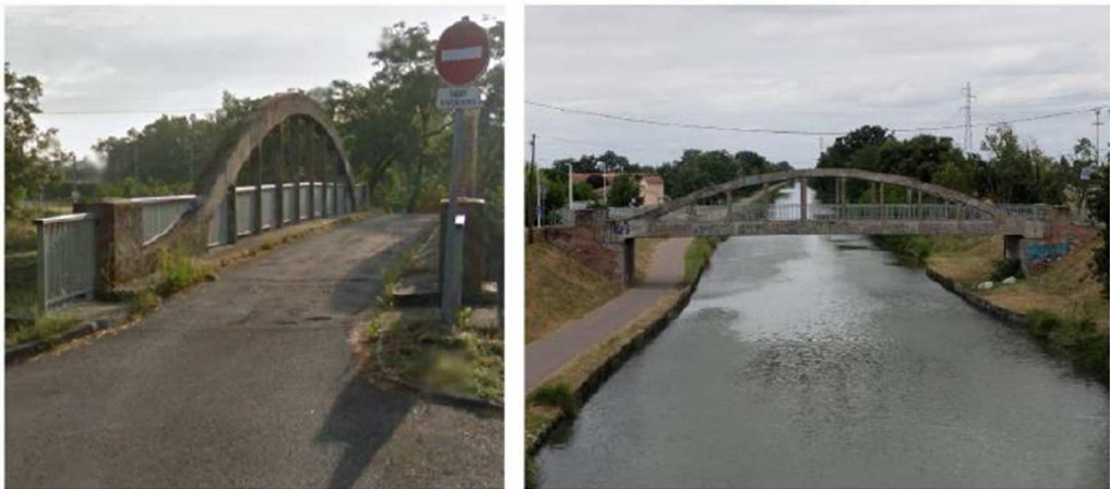
Pont existant sur le Canal au niveau de Saint-Jory et pont existant sur le Canal au niveau de Fenouillet :
