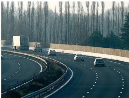
Exemple d'écrans acoustiques avec bardage bois le long d'une infrastructure routière
