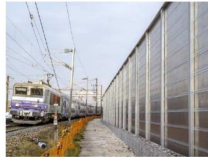
Aménagement d'un écran acoustique sur le domaine ferroviaire avec bardage bois (vue emprises ferroviaires) - Projet SNCF - Saint-Denis (93)
