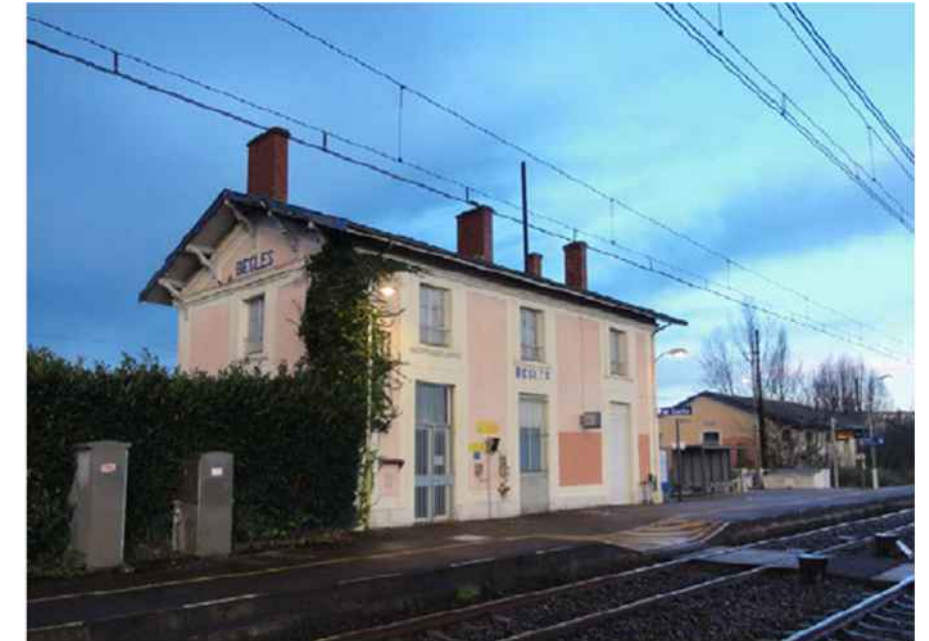
La gare de Bègles (Source : Egis, 2013)
