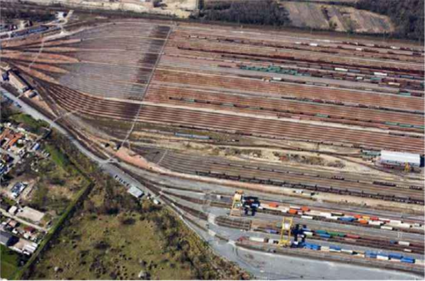
La gare de triage d'Hourcade (Source : SNCF RÉSEAU, 2012)
