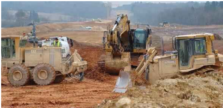
Figure 127 : Travaux de terrassement sur un chantier (Source : SNCF RÉSEAU)
