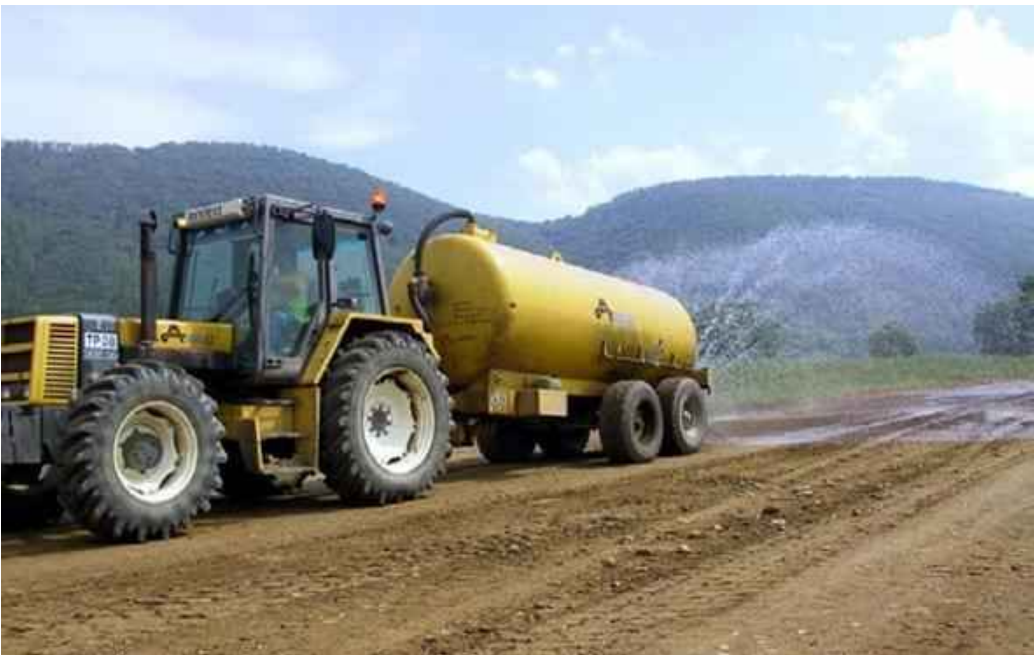
Figure 128 : Arroseuse sur un chantier (Source : Egis)
