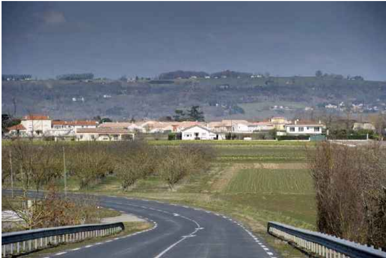
Figure 73: La RD292 au niveau du franchissement de l'A62, commune de Roquefort (Source : SNCF Réseau - Paul Robin)
