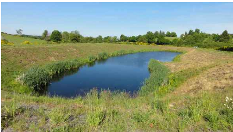
Figure 89: Bassin d'écêtement (Source : Egis)
