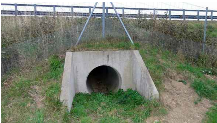
Figure 85: Ouvrage de type 3 (Source : Egis)
