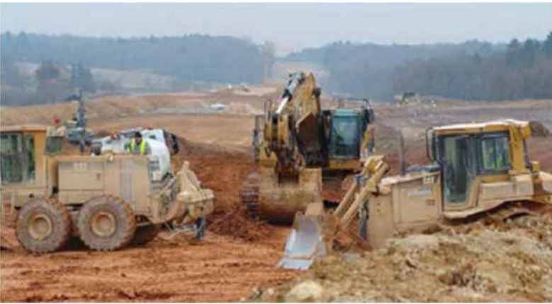
Figure 119 : Travaux de terrassement sur un chantier (Source : SNCF Réseau)
