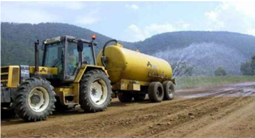
Figure 121 : Arroseuse sur un chantier (Source : Egis)
