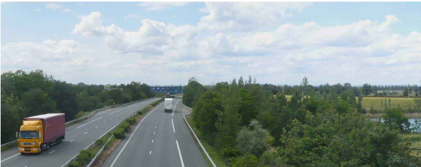
Figure 138: L’autoroute A62, commune de Saint-Porquier (Source : Egis)
