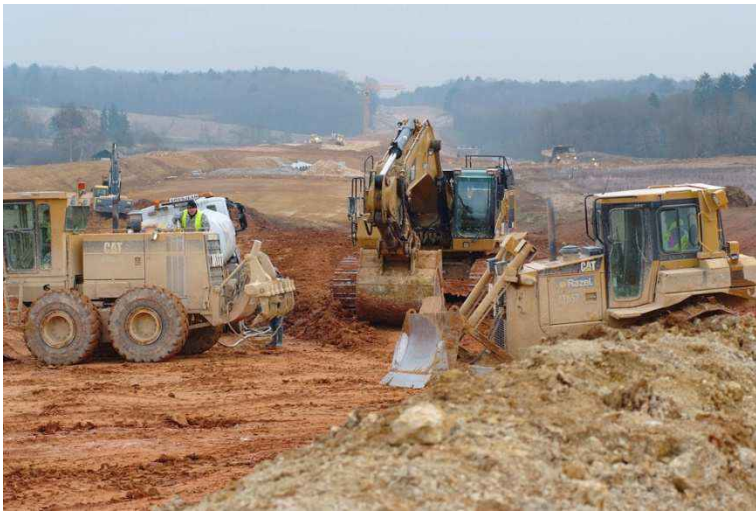
Figure 139 : Travaux de terrassement sur un chantier (Source : SNCF RÉSEAU)
