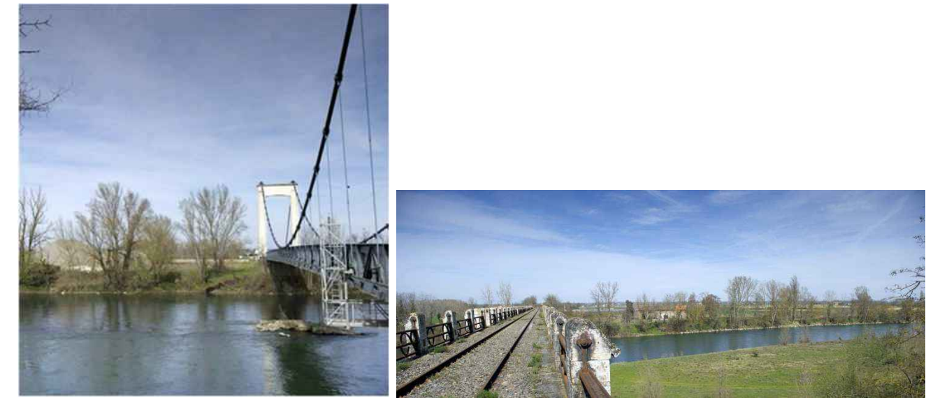
Figure 95 : Les franchissements existants de la Garonne à Cordes Tolosannes (Source : SNCF RÉSEAU - Paul Robin)
