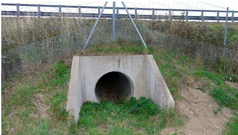
Figure 92: Ouvrage de type 3 (Source : Egis)
