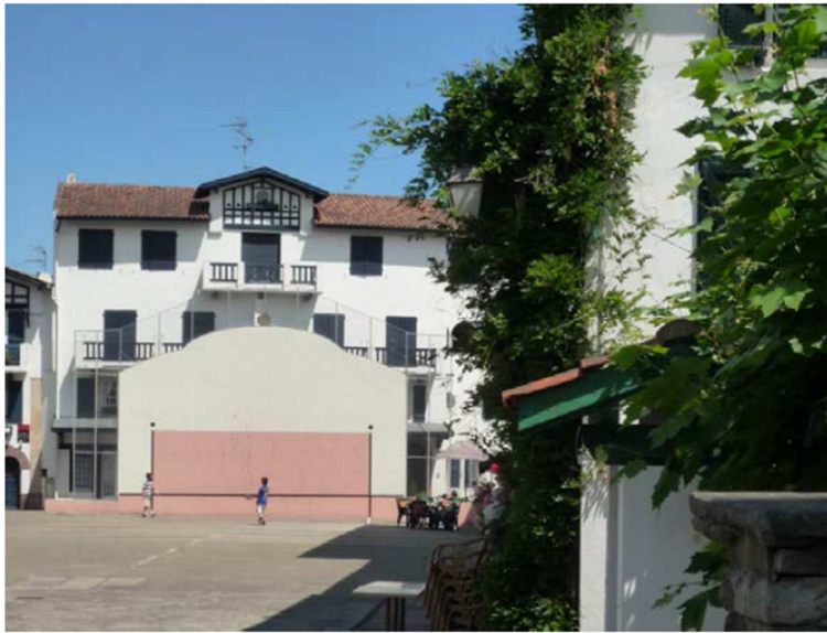
Figure 154: Fronton à Ascaïn (Source Egis rail.)
