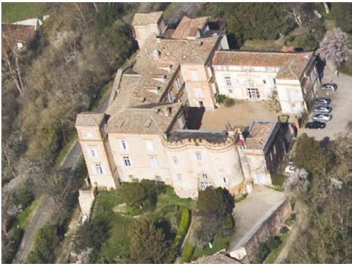
Figure 151: Le château de Castelnau-d’Estrétefonds, en Haute-Garonne (Source FIT Conseil)
