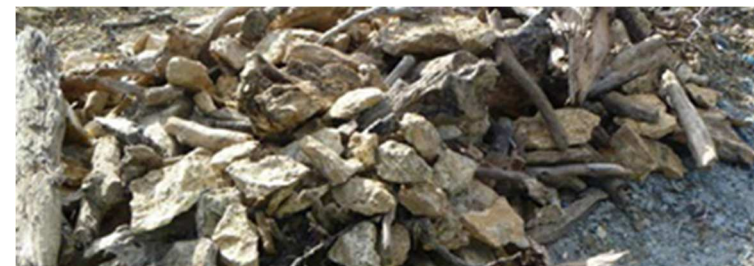
Figure 373: Hibernaculum en cours de construction (Source : Écosphère)
