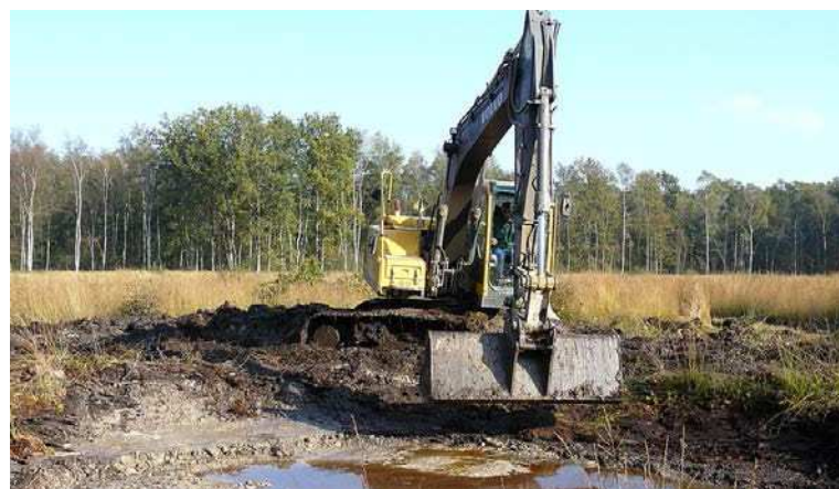
Figure 368: Travaux de terrassement du profil des berges d'une mare (Source : Écosphère)
