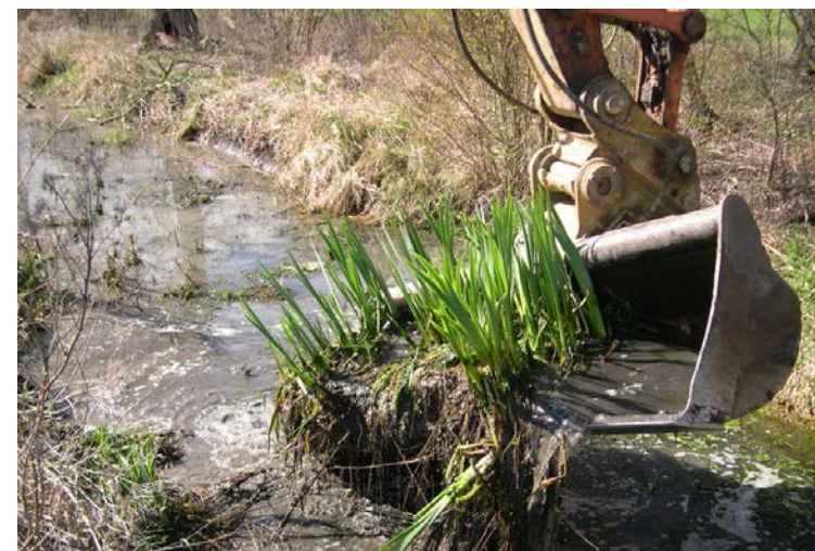
Figure 369: Exemple d'utilisation du matériel végétal à proximité : hélophytes pris dans un ru à l'occasion de son curage, pour végétaliser des zones humides créées aux abords (Source : Écosphère)
