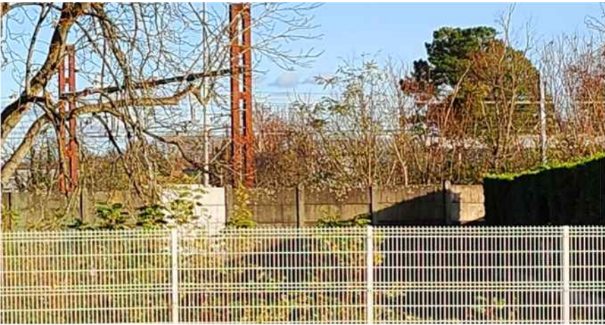
Zoom sur la clôture de béton ancienne qui sera remplacée
