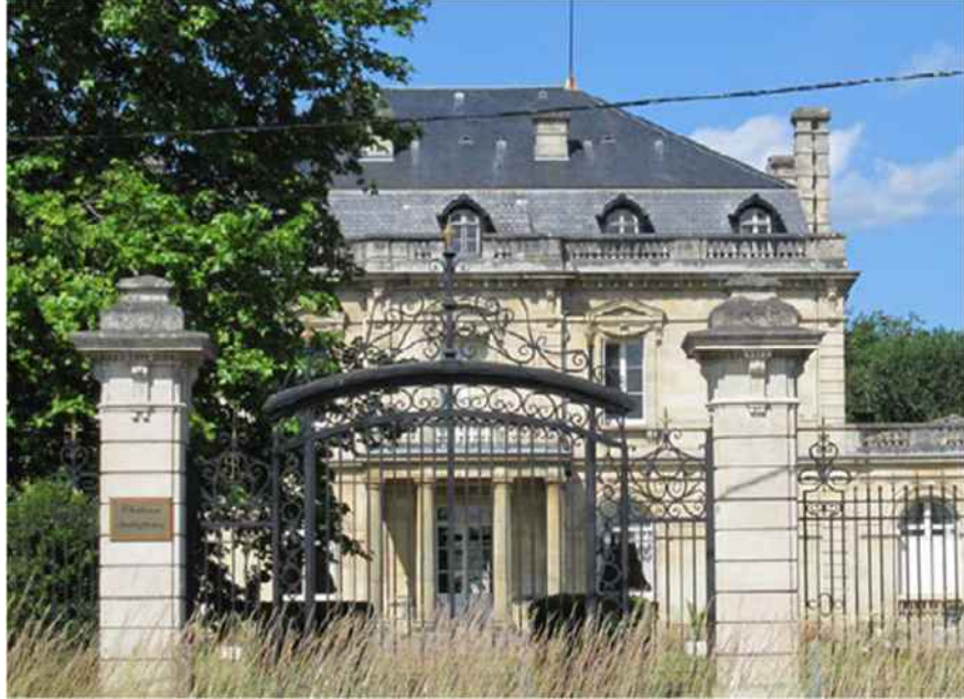
Château de Millefleurs (Source : SNCF Réseau, 2012)
