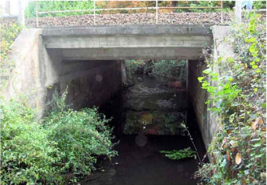
Ouvrage existant de franchissement de l’Eau Blanche par la ligne ferroviaire Bordeaux-Sète (Source : Egis, 2012)
