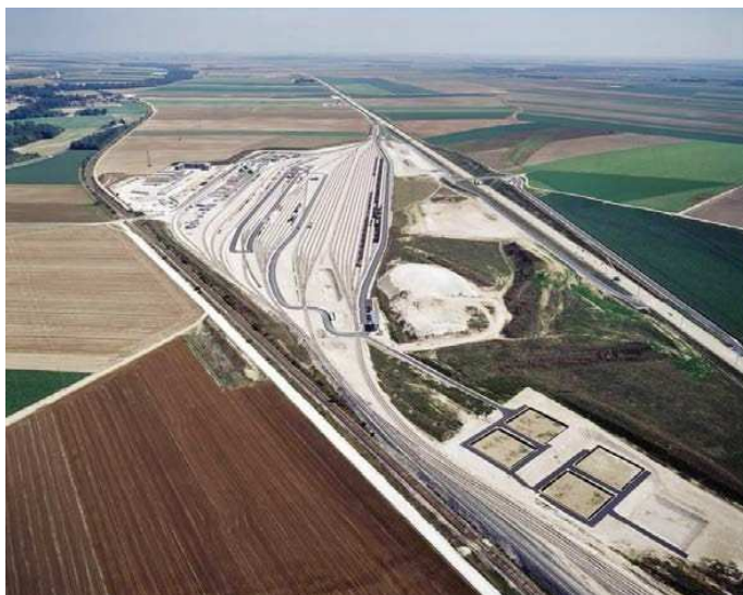
Figure 256: Base travaux de Vadenay - Saint-Hilaire-au-Temple sur la LGV Est européenne (source : SNCF RÉSEAU)
