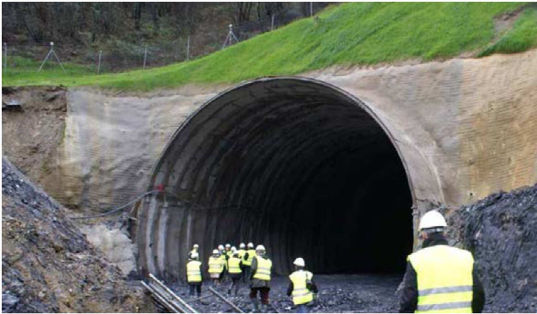
Figure 243: Travaux de réalisation du Y basque (Source : Ineco)
