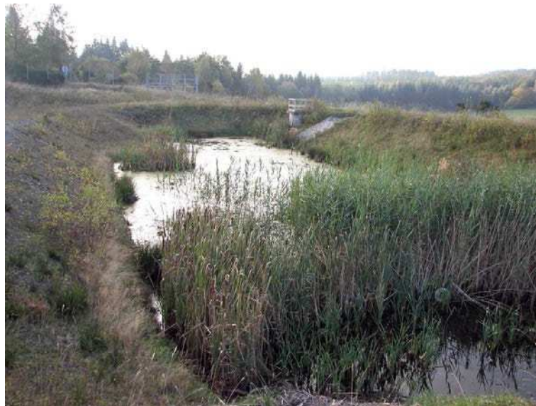
Figure 270: Bassin d'écêtement (Source : Egis)
