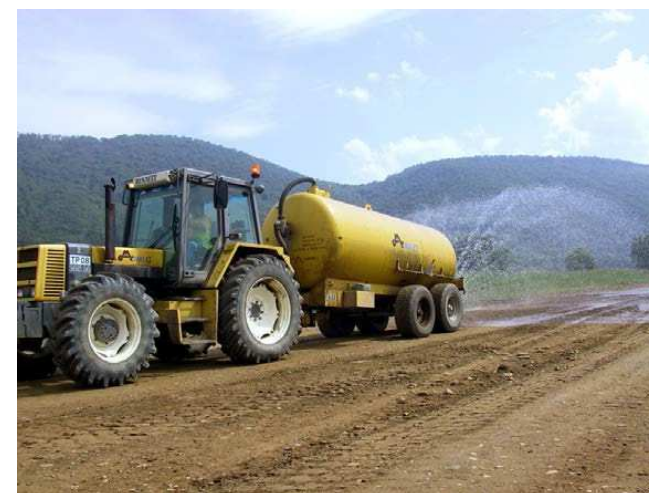
Figure 273: Arroseuse sur un chantier (Source : Egis)
