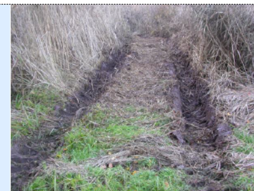
Figure 1 : Ornières trop importantes justifiant le report des travaux – Renaturation de zones humides, CSA
