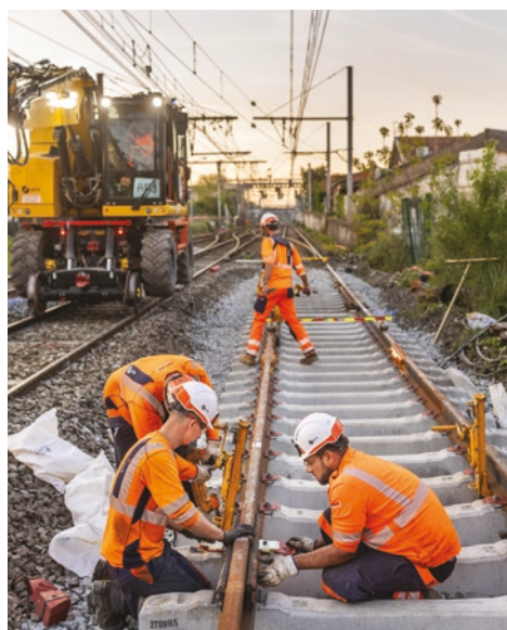
À Bègles, réfection des voies ferrées à proximité de la gare ferroviaire.
