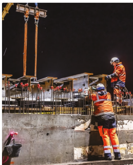
À Cadaujac, reconstruction et agrandissement du pont de la rue des Marguerites, pour une mise en service en septembre 2026.
