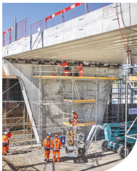
À Saint-Médard-d'Eyrans, construction d'un nouveau pont dans la zone du Cordon d'Or.
