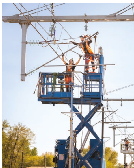
À Villenave-d'Ornon, travaux de modernisation des caténaires.
