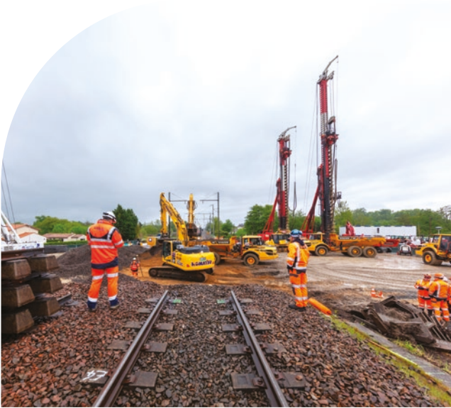
Réalisation de l'enceinte étanche
