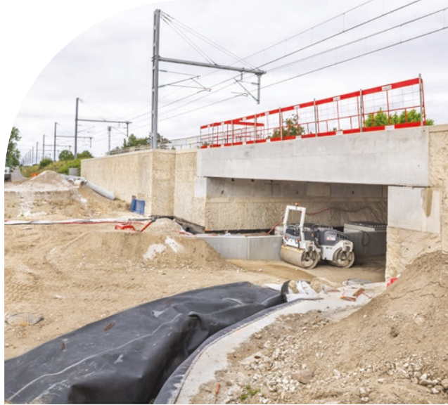
Aménagements progressifs des voies d'accès
